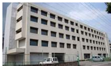
生産センター (京都市下京区)
