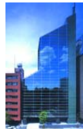
東京営業所 (高輪台グリーンビル9F)
